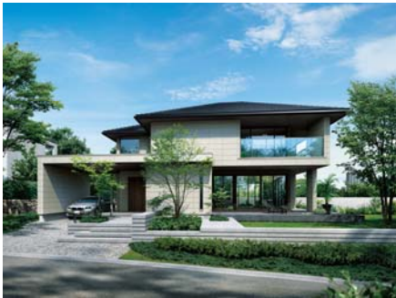
戸建住宅(鉄骨造)
